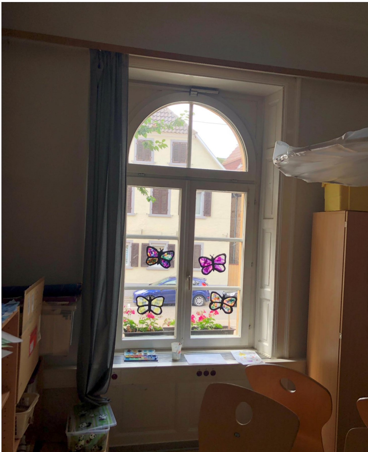
Innenansicht Fenster Erdgeschoss (Brüstungslambrie bereits entfernt.)
